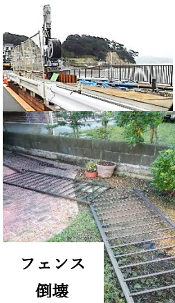
稲村遊歩道修理中
